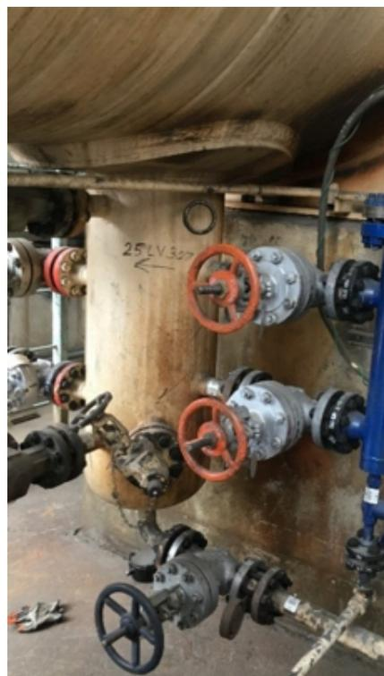
Figure 9 : Boot de séparation dans une raffinerie (transmetteur GWR installé dans la chambre bleue à droite)
