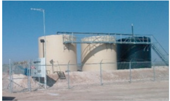
Emplacement du puits d'injection
