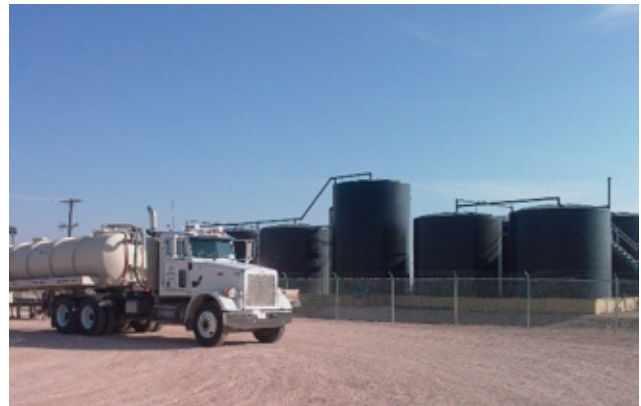
Abbildung 7: Tankwagen beim Entladen in eine Tankanlage für die Lagerung und Abscheidung von Salzwasser und Öl
