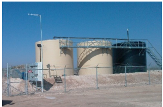
Abbildung 8: Standort der Injektionsbohrung
