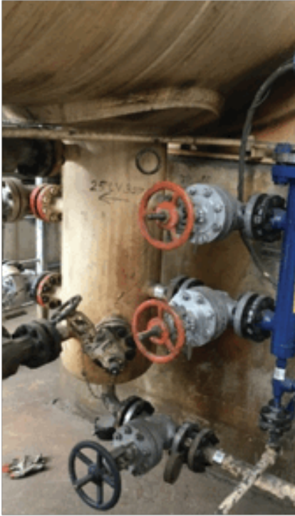
Raffinerieanlage mit „Boot“ als Flüssig-Flüssig-Abscheider
