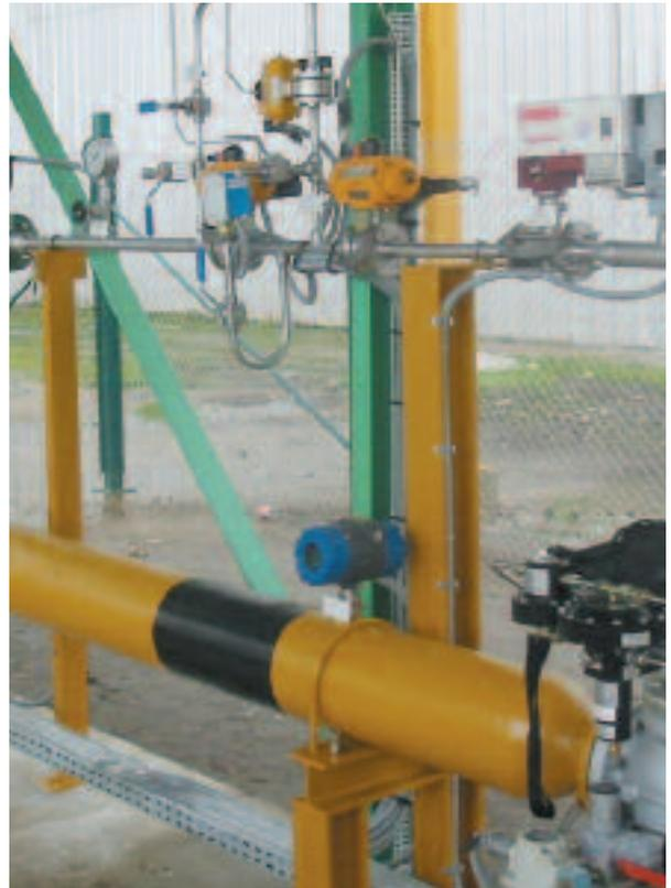
Il biogas, una miscela di metano e anidride carbonica, deriva dalla decomposizione di materiale organico e può essere utilizzato come combustibile. A causa della sua sensibilità alle basse portate e dei ridotti cali di pressione, TA2 è un flussimetro eccellente per misurare i biogas.
