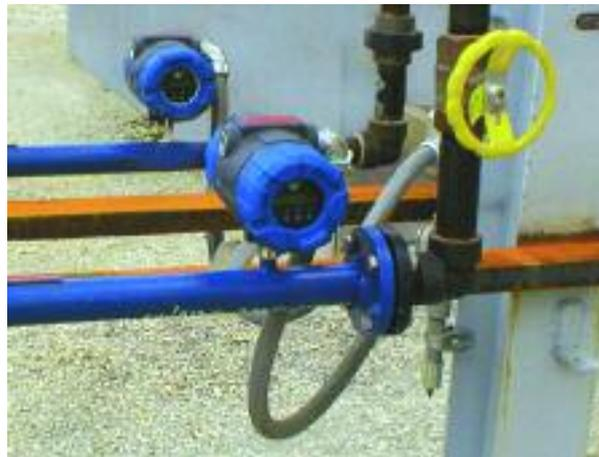
Il flusso di azoto in una linea di circa 5 cm di diametro in un impianto chimico. Il consumo sul punto d'utilizzo dell'aria compressa e dei gas permette all'utente di ottenere migliori informazioni sul tasso di utilizzo, per operazioni più efficienti. Alcune strutture centralizzate effettuano la rendicontazione dell'utilizzo del gas per singolo impianto.
