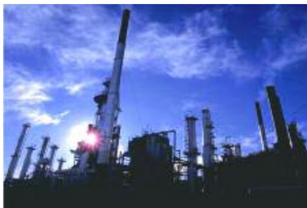
L'idrogeno gassoso ha molte applicazioni industriali. Utilizzando un catalizzatore e grandi quantità di idrogeno, il trattamento idrogenante (sopra) rimuove il 90% dello zolfo, dell'ossigeno e dei metalli dalle materie prime per la raffinazione della benzina.
