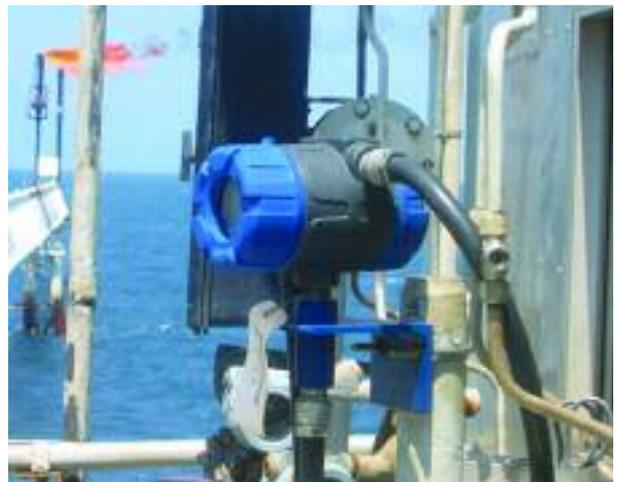
Per conformità alle leggi e ai regolamenti in campo ambientale, gli operatori sulle piattaforme petrolifere o di estrazione di gas devono monitorare e riportare la quantità di gas bruciati. La composizione coerente, la sensibilità alle basse portate e un rapporto portata massima/minima elevato rendono TA2 un flussimetro ideale per questo servizio.
