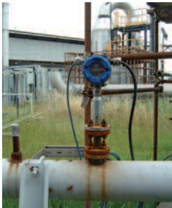
L'efficienza di combustione di bruciatori, forni ed essiccatoi risulta potenziata grazie a una misurazione ripetibile del flusso dell'aria di combustione in ingresso. Il diametro dei condotti può variare da 15 cm a vari metri. Se l'aria è insufficiente la combustione è incompleta; se l'aria è eccessiva l'efficienza di combustione risulta notevolmente ridotta.
