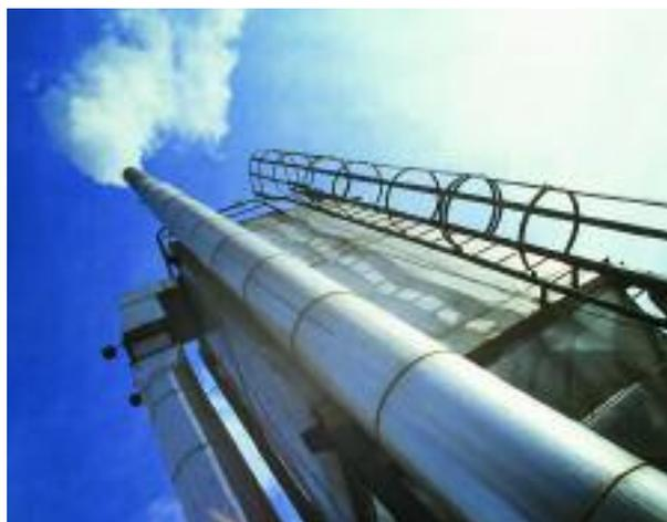
Si può misurare il flusso di condotti e altoforni di grandi dimensioni, come in questa caldaia per la produzione di energia, usando più TA2 standard per ottenere una media della portata. Questo approccio è più economico e meno impegnativo dal punto di vista della manutenzione rispetto ai sistemi di array multipunto concepiti su misura per il cliente.
