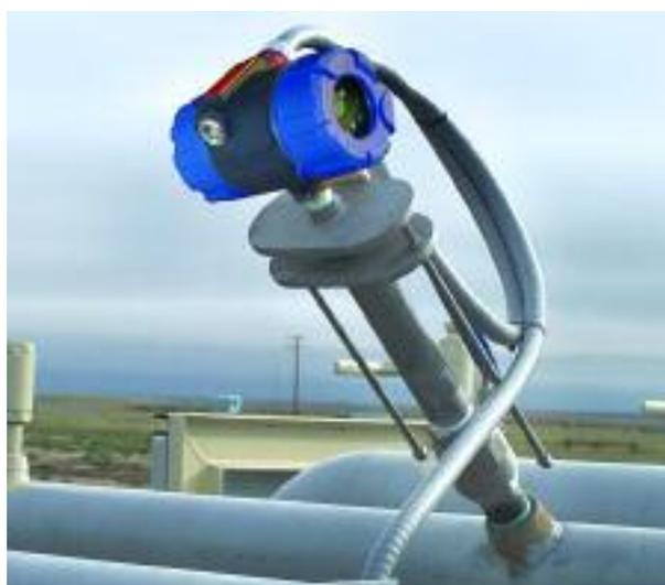
I gruppi sonda rimovibili (RPA) permettono di installare lo strumento in applicazioni che devono rimanere continuamente operative. Sono disponibili modelli di gruppi sonda con valori nominali di pressione fino a 50 bar.
