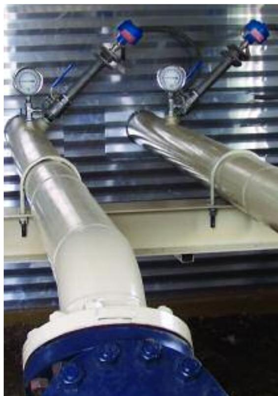
Il flusso di gas naturale in un impianto di produzione del gas viene monitorato per fornire una misurazione di flusso da ogni singolo pozzo. Il principale misuratore di trasmissione è situato a valle rispetto al punto in cui si combinano i flussi delle singole linee.
