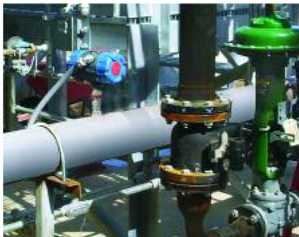
Il gas naturale è una delle principali fonti di energia per alimentare grandi centrali, nonché fornaci e caldaie industriali più piccole. La misurazione delle portate e il totale della portata utilizzata sono fondamentali per un funzionamento efficiente.
