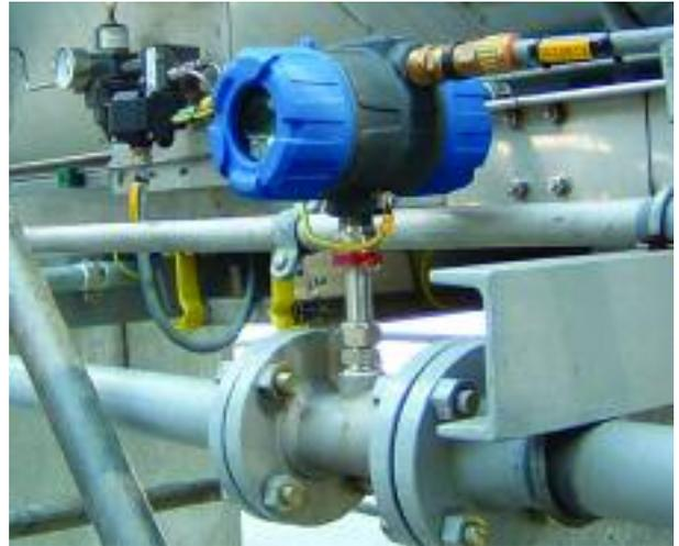
Misurazione del flusso di gas naturale in una fornace. L'utilizzo di una sonda a inserimento permette di installare TA2 su linee di varie dimensioni e con una notevole flessibilità di installazione mentre assicura una misurazione della portata massica economicamente conveniente.
