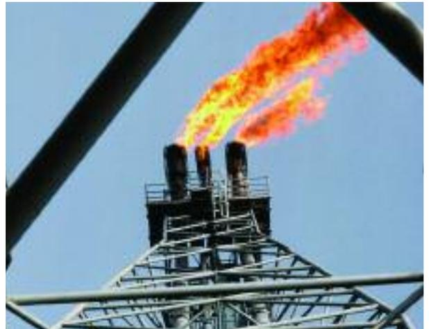
Le raffinerie e gli impianti chimici odierni bruciano spesso i gas di scarico (esausti) in un camino. Poiché sia la portata che la composizione dei gas variano, si può utilizzare TA2 per ottenere un'indicazione di flusso relativa.
