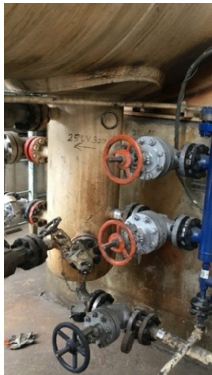
Рисунок 9. Отстойник для сепарации на нефтеперегонном заводе (волноводный радарный уровнемер находится в синей камере справа)
