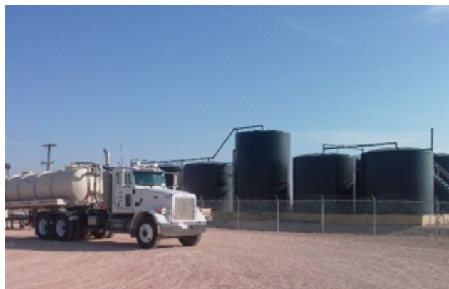
Рисунок 7. Автоцистерна, разгружающаяся в резервуар-отстойник для хранения и сепарации минерализованной воды от нефти
