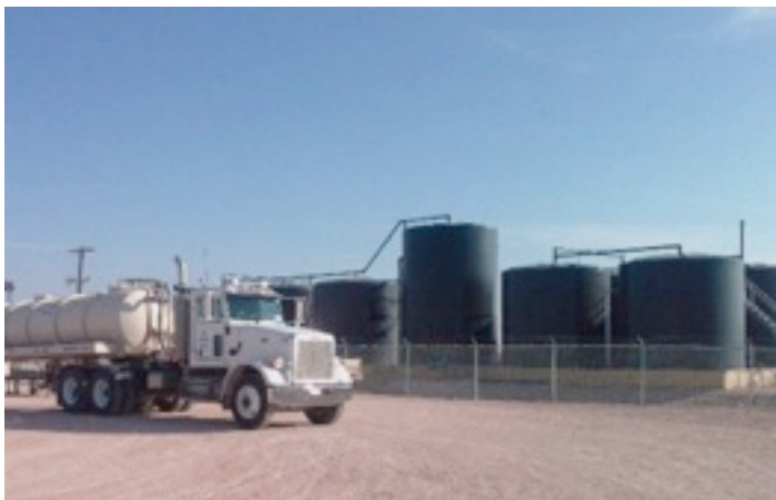
Автоцистерна, разгружающаяся в резервуарный парк для хранения и сепарации минерализованной воды / нефти
