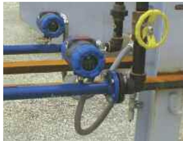
Измерение расхода азота в трубе диаметром два дюйма на химическом заводе. Адресное измерение расхода сжатого воздуха и газов позволит пользователю получать более точную информацию о их потреблении, что повысит технологическую эффективность. Некоторые заводы с централизованной системой управления выставляют счета отдельным установкам за потребленный газ.
