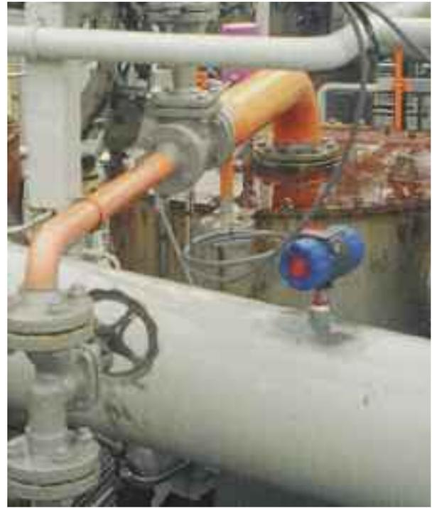
Эффективность горения в печах, горелках и сушилках повышается за счет получения повторяемых измерений расхода воздуха горения. Размеры труб могут колебаться от 6 дюймов в диаметре до нескольких квадратных футов в сечении. Если воздуха не достаточно, горение неполноценно; если воздуха слишком много, то эффективность горения резко падает.
