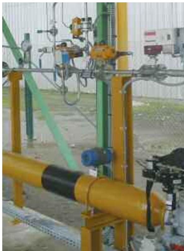
Биогаз, смесь метана и углекислого газа, образуется в процессе распада органических материалов и может использоваться в качестве топлива. Благодаря чувствительности к слабым расходам и низкому падению давления, расходомер TA2 идеально подходит для измерения биогаза.
