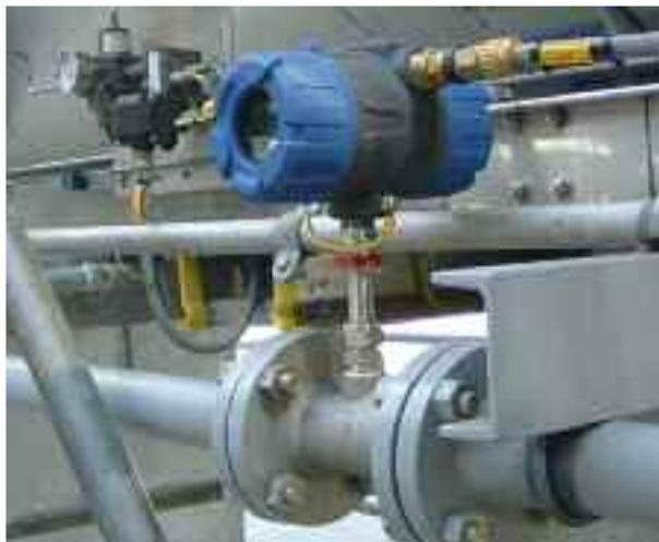
Измерение расхода природного газа, потребляемого печью. Использование расходомера съемного типа с зондом позволяет устанавливать TA2 в трубы различного диаметра, что обеспечивает гибкость монтажа и экономичность измерения массового расхода.
