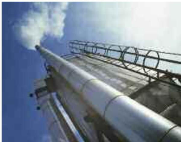
Расход газа в трубопроводах и дымовых трубах большого диаметра, таких, как изображенная на рисунке дымовая труба котла электростанции, можно измерить при помощи нескольких расходомеров TA2, рассчитав их среднюю величину расхода. Этот простой подход более экономичен по сравнению с применением изготовленных по специальному заказу матриц многозонных сенсоров.
