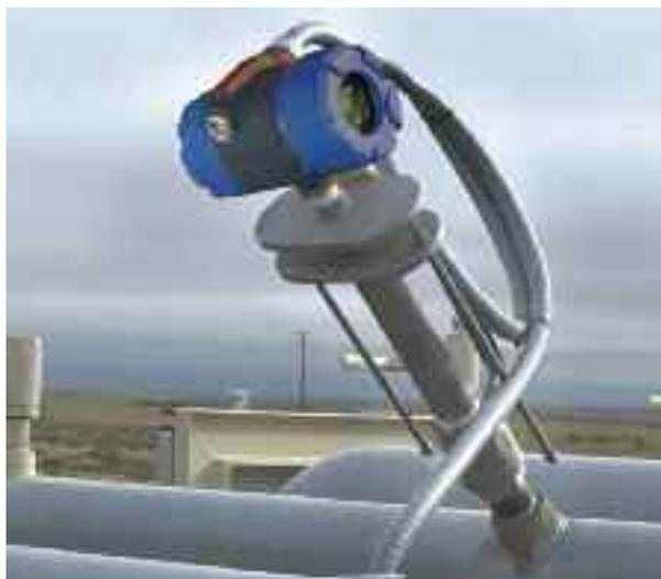
Устройство горячего ввода и извлечения зонда позволяет производить монтаж расходомеров там, где прерывание производственного процесса недопустимо. Есть устройства, спроектированные для высокого давления, до 50 бар.
