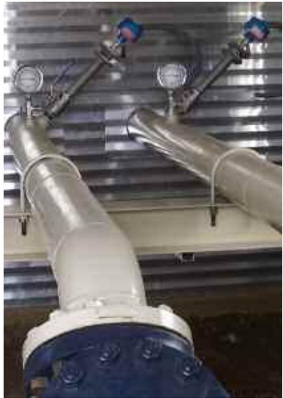
Измерение расхода природного газа внутри газодобывающей установки ведется для учета индивидуального дебита каждой скважины. Основной учетный расходомер узла приема-передачи природного газа располагается в общей трубе после схождения патрубков от скважин.
