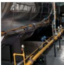
La tecnología de control de flujo optimiza el índice aire-combustible, administra el consumo de energía y monitorea el flujo de gas, previniendo desperdicio de energía detectando fugas de aire.
