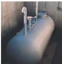
La instrumentación de nivel en el almacenaje de químicos debe resistir su corrosión, no mostrar afectación por cambios en el espacio de vapor y proporcionar verificación de desempeño y visibilidad durante la transferencia del producto.
