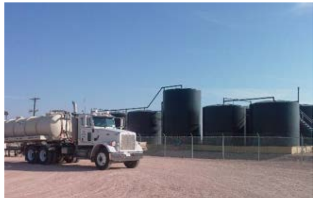
Figura 7: Camión descargando a la batería de almacenaje y separación de agua / crudo
