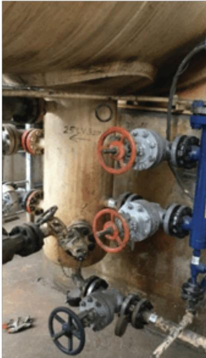
Bota de separación líquido-líquido en una refinería
