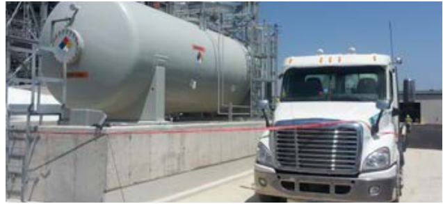
Indicador magnético de nivel de alta visibilidad con un transmisor de nivel magnetostrictivo facilita la labor de descarga de amoníaco en una planta de ciclo combinado
